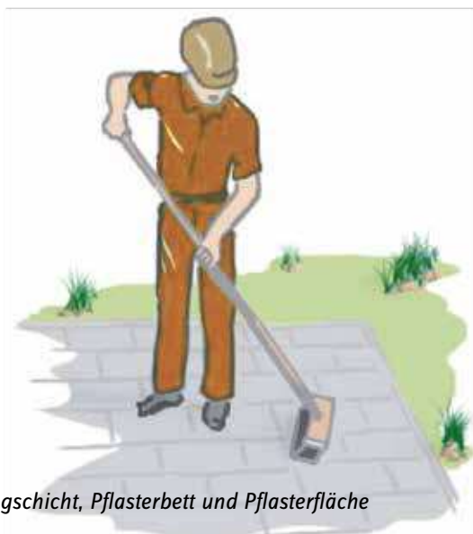
Steine scheibenweise aus mehreren Paketen mischen
