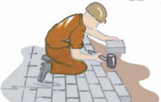
Pflastersteine lotgerecht verlegen
