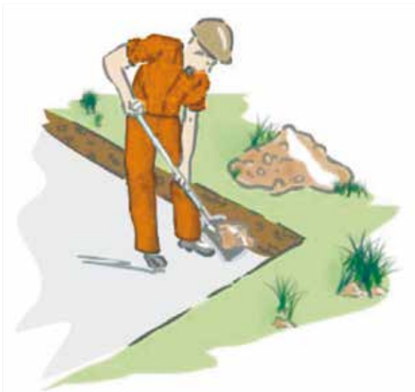
Nicht tragfähige Bodenschichten abgraben
