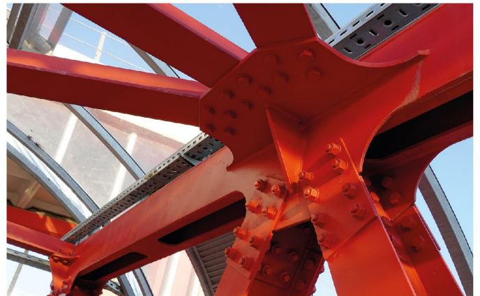
• โครงสร้างเหล็ก
