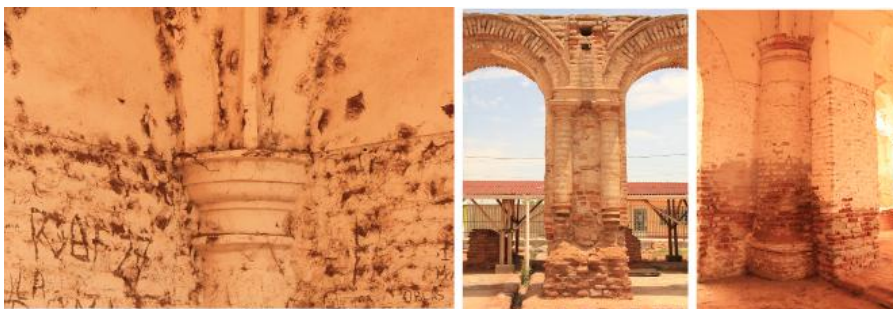
fig. 06. Pilares y Pilastras.
