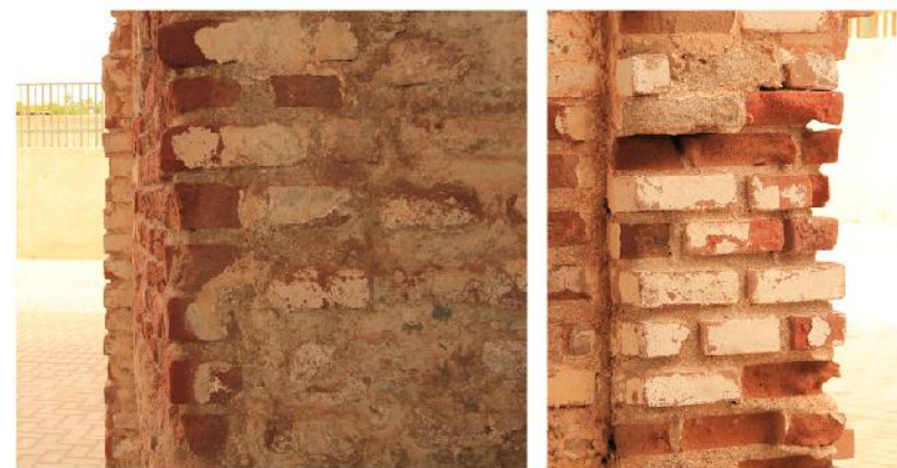
fig. 05. Muros de ladrillo.
