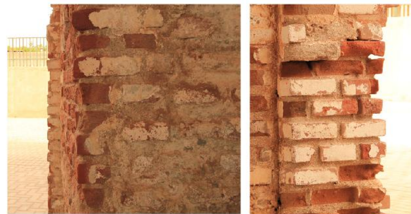
fig. 05. Muros de ladrillo.
