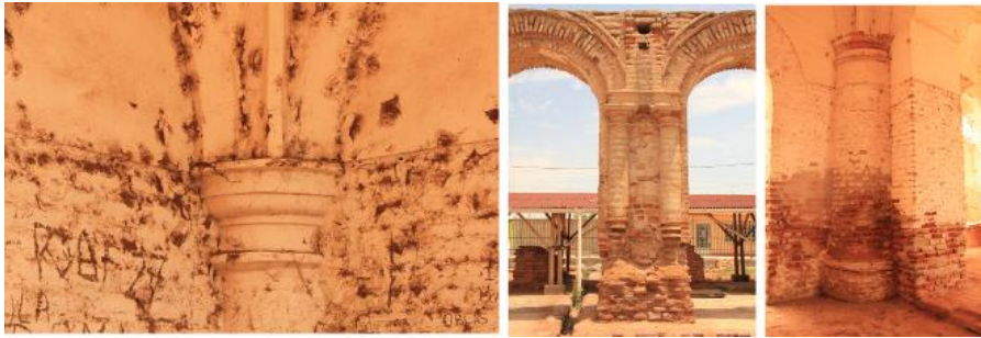
fig. 06. Pilares y Pilastras.
