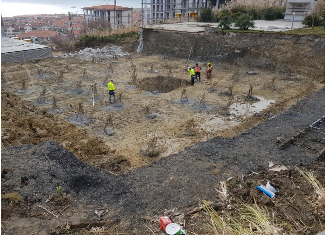
Bitmiş Fore Kazık Uygulaması (Bahar Rezidans)
