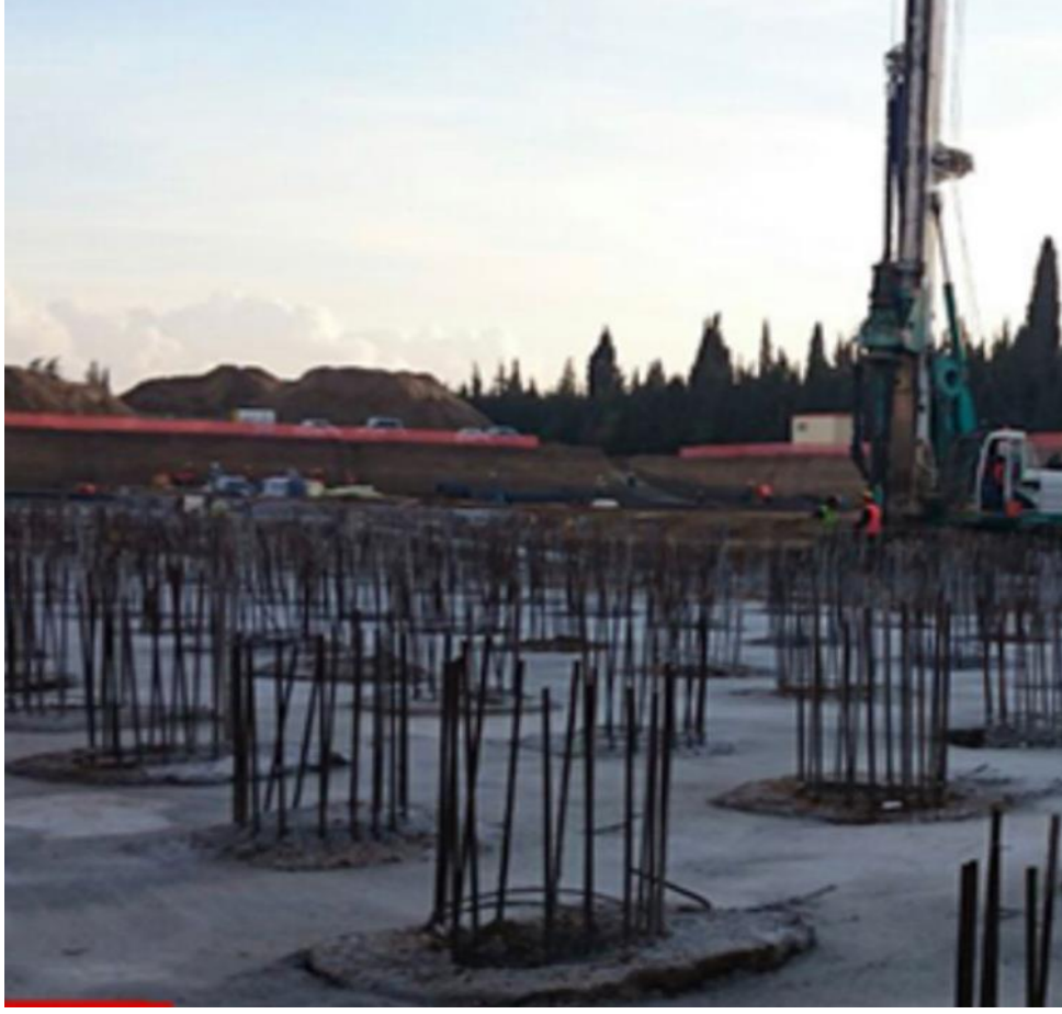
Bitmiş Fore Kazık Uygulaması (Bahar Rezidans)
