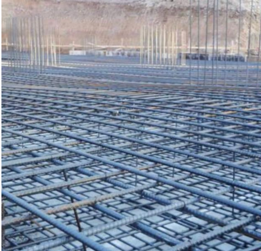
Temel Donatı İmalatları (Bahar Rezidans)
