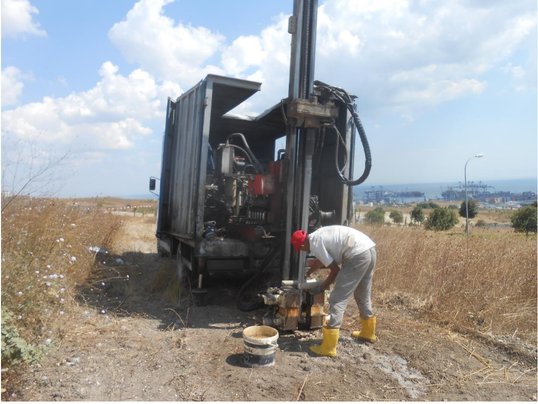
Zemin Etüt İçin Boş Arazide Sondaj Çalışması (Mercan-2)
