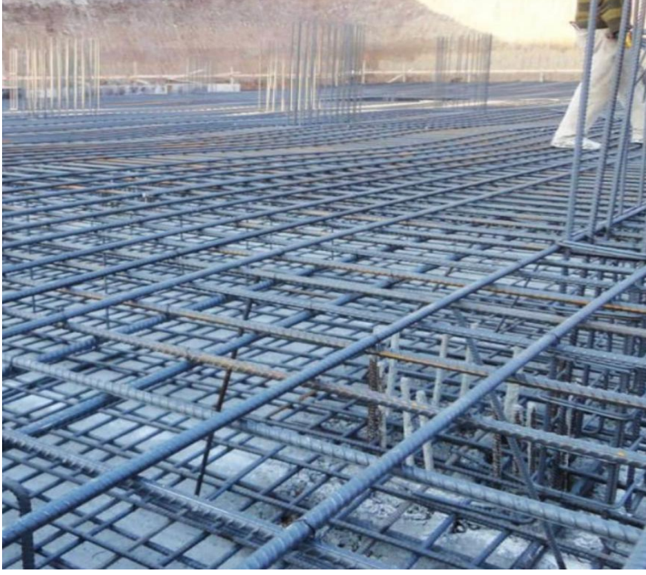
Temel Donatı İmalatları (Bahar Rezidans)
