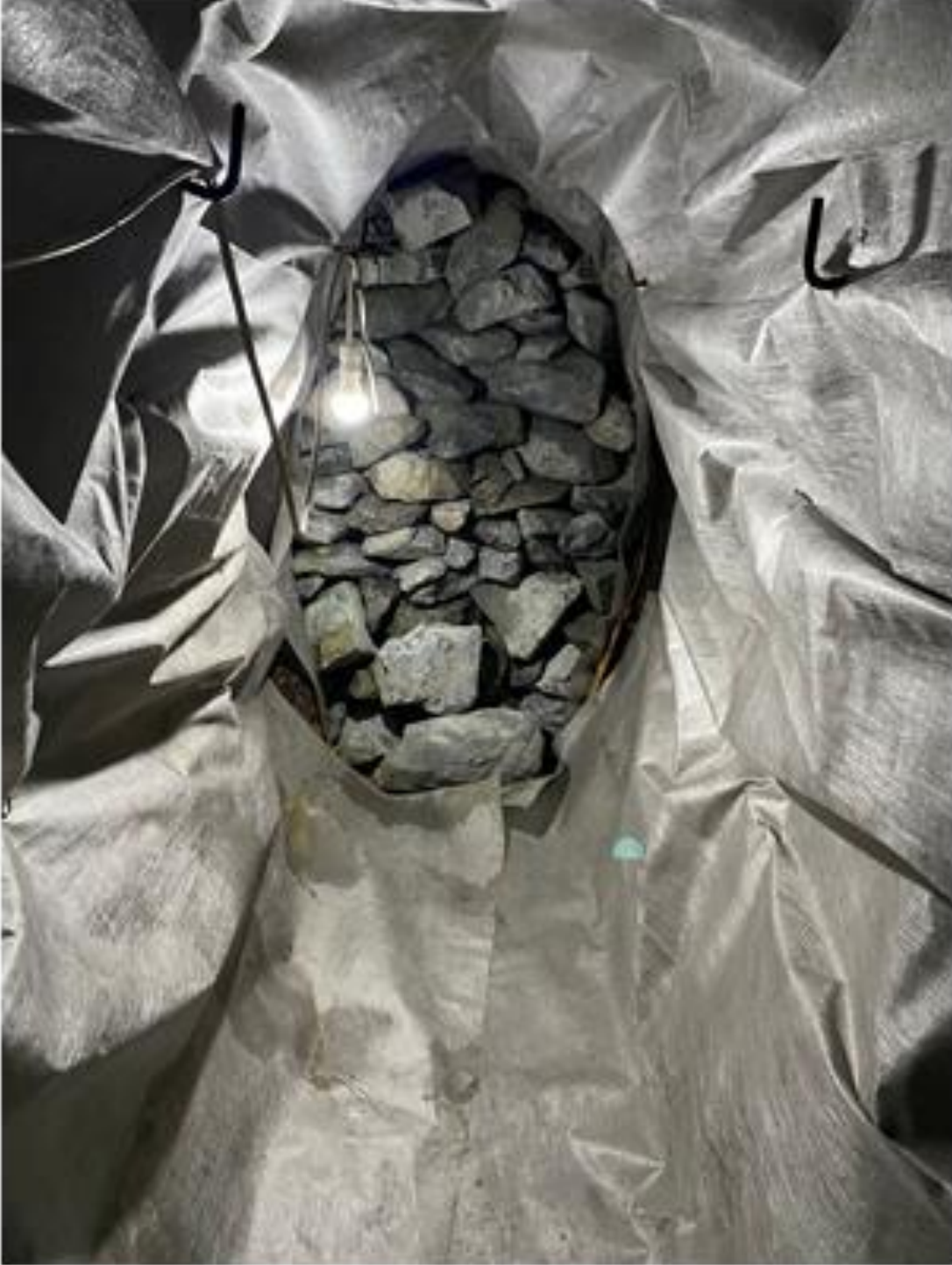
Geotekstil serilmiş galeri imalatına serilen mıcır
