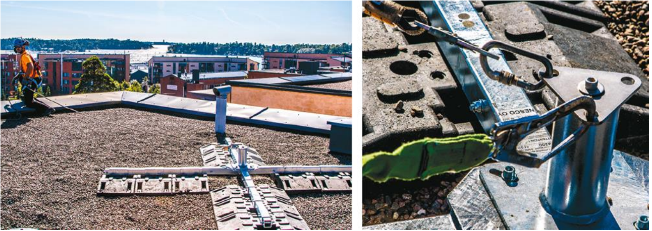
Kuva 1. Vastapainoankkuri, paino 374 kg
