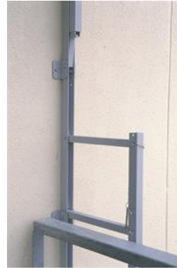
Kuva 3. Tikas aukaistuna jatkoksen kohdalla
