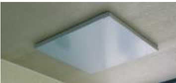
Kuva 3. Alakansi parvekkeen katossa
