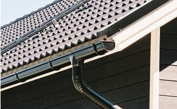
Kuva 1. P13 kouru ulkopuolisella kannakkeella ja liukulähtö
