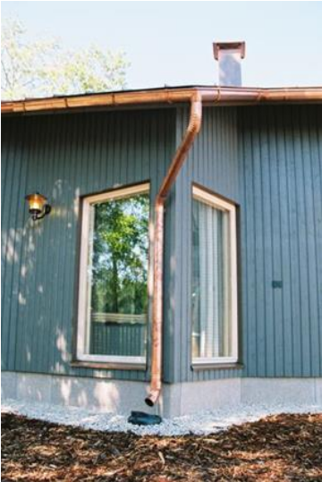
Kuva 3. P13 kuparikouru ja 100 mm kuparisyöksy
