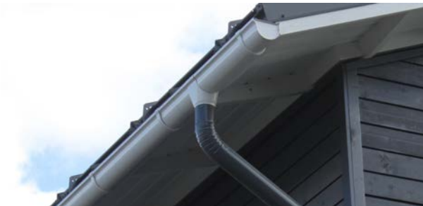
P13 kouru ulkopuolisella kannakkeella ja liukulähtö
