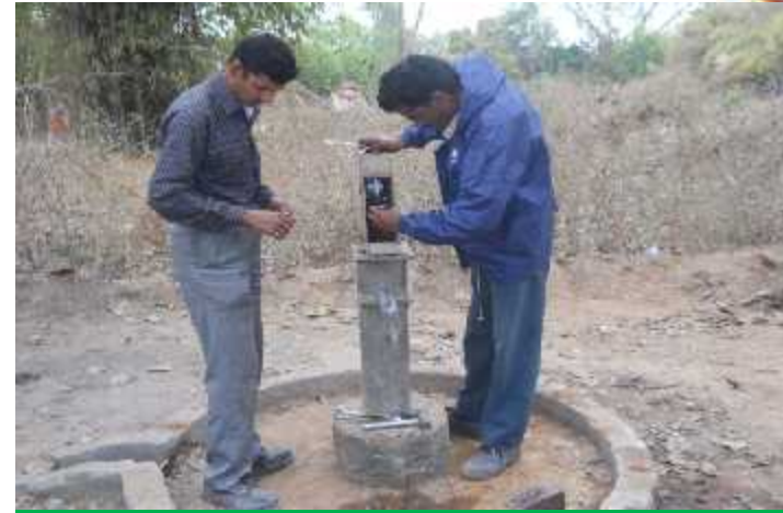
ग्राम टुण्डी में हैण्डपंप का मरम्मत
