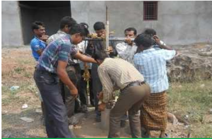
ग्राम टुण्डी में हैण्डपंप का मरम्मत
