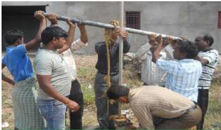
ग्राम टुण्डी में हैण्डपंप का मरम्मत
