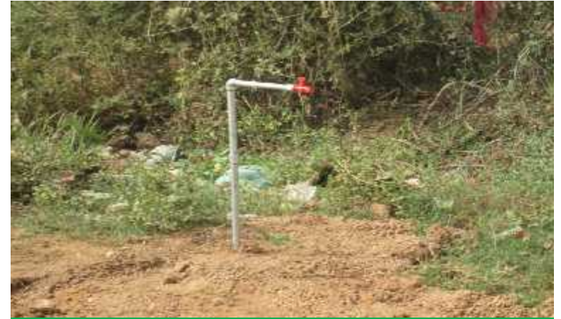
ग्राम बाड़ादरहा में स्टैण्डपोस्ट की स्थापना
