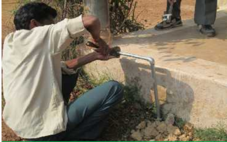
ग्राम बाड़ादरहा में स्टैण्डपोस्ट की स्थापना
