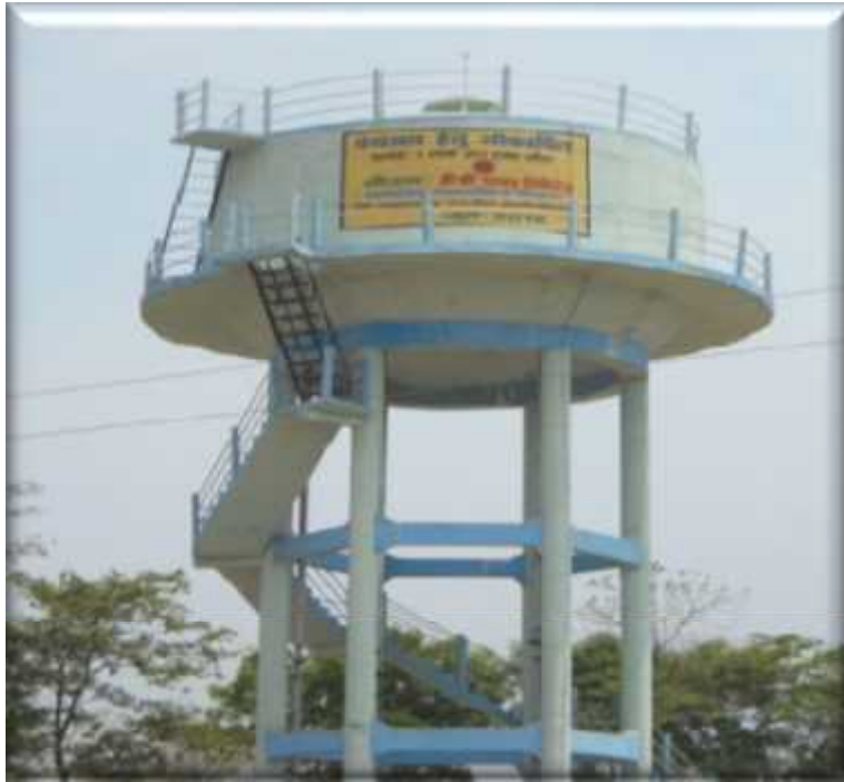
पानी टंकी का निर्माण
