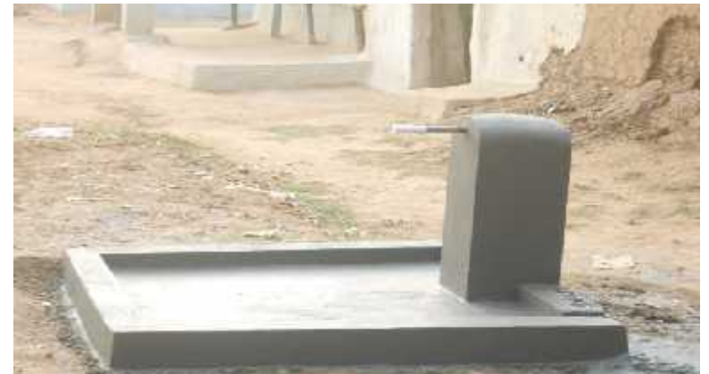
ग्राम बाड़ादरहा में स्टैण्डपोस्ट की स्थापना
