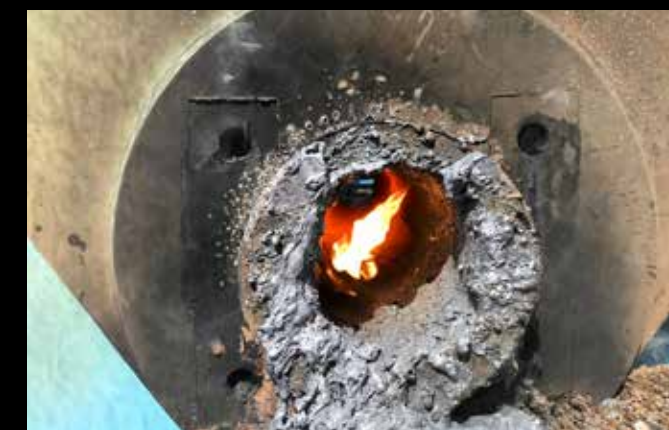
Tijdens het branden van het slooppgat (ca. 5200 graden) wordt ook het vet dat om de as heen zit vloeibaar en ontbrandt het. (Beeld: Duikbedrijf COW)
