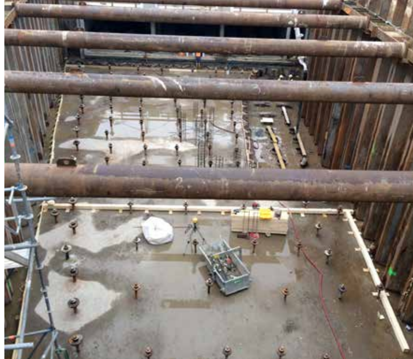
Leeggepompte bouwkuip met Gewi ankers na aanbrengen en uitharden van het onderwater beton. (Beeld: Duikbedrijf COW)
