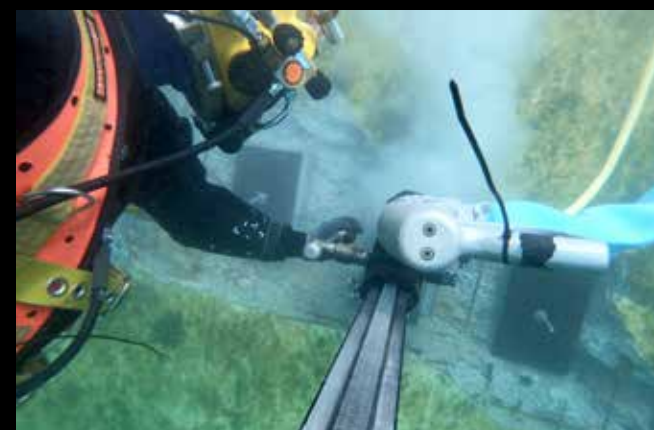
Kernboren voor uitvoering hoogwaardige betonreparatie onder water. (Beeld: Johnathan de Kok)
