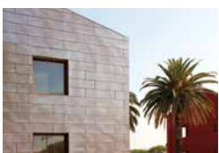
Villa Madré, Pisa, I Re Salvatore Architetto, Pisa Romano Donato Lattonerie S.r.l., Montevarchi TECU® Oxid
