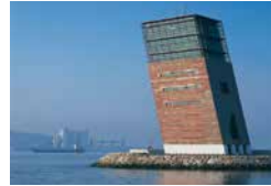
Harbour Control Tower, Lisbon, P Gonçalo Byrne, G.B. Arquitectos, Lisbon Zn-Revestimentos de Zinco Lda., Maia TECU® Classic
