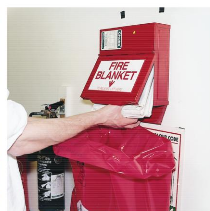
Asbestos fire blanket
