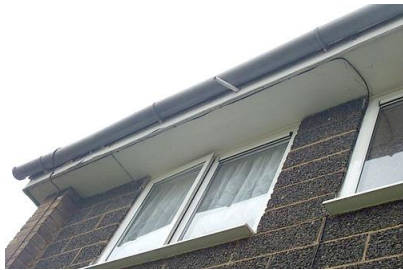
Asbestos soffits
