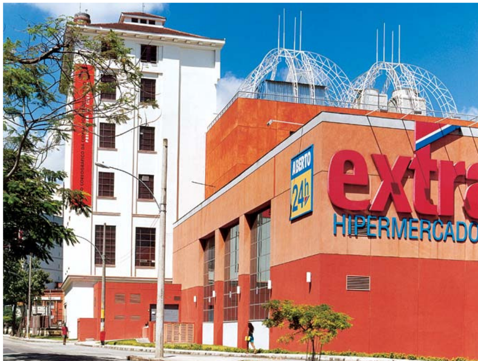
Sobre o hipermercado fica o volume anexo, marcado pela releitura das cúpulas demolidas
