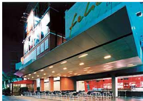
A marquise não encosta na parede para dar relativa independência à varanda; vigas de aço corten delimitam os panos de vidro
