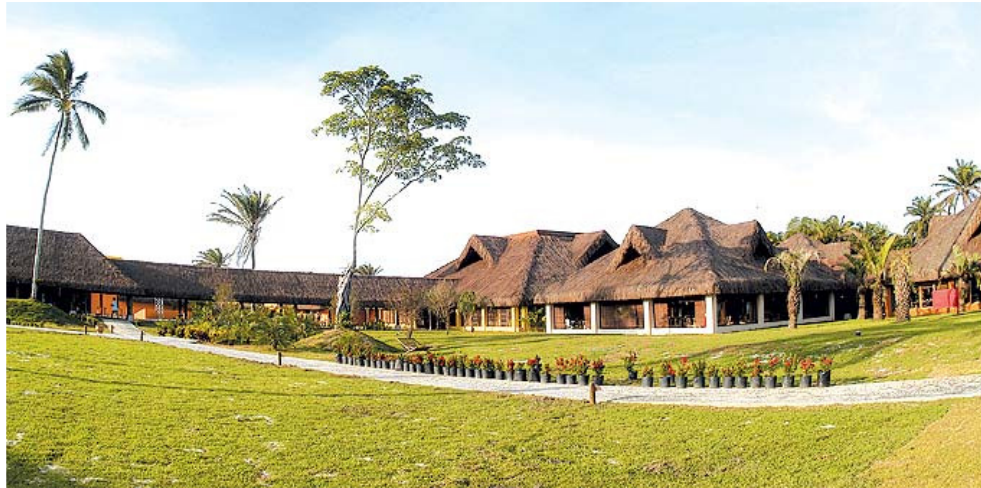
Vista geral do empreendimento evidenciando construções com estrutura de madeira e cobertura de piaçava
