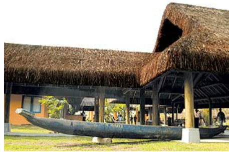
A recepção com lobby aberto integra-se ao exterior. Mansardas favorecem a ventilação natural
