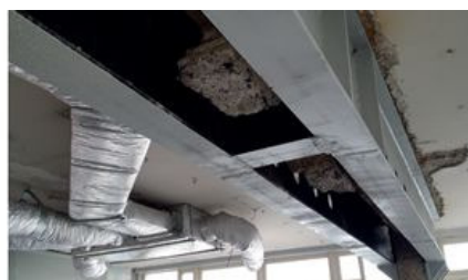
Mãos-francesas foram substituídas por vigas metálicas duplas para absorver as cargas incidentes
