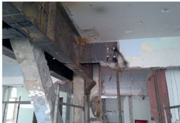
As novas vigas metálicas foram ligadas à estrutura original por meio de consoles chumbados. Como não se tratavam de cargas novas, não foi necessário adaptar a estrutura original
