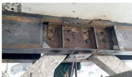
Mãos-francesas foram substituídas por vigas metálicas duplas para absorver as cargas incidentes
