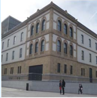
Edificio Tabacalera (San Sebastián)
