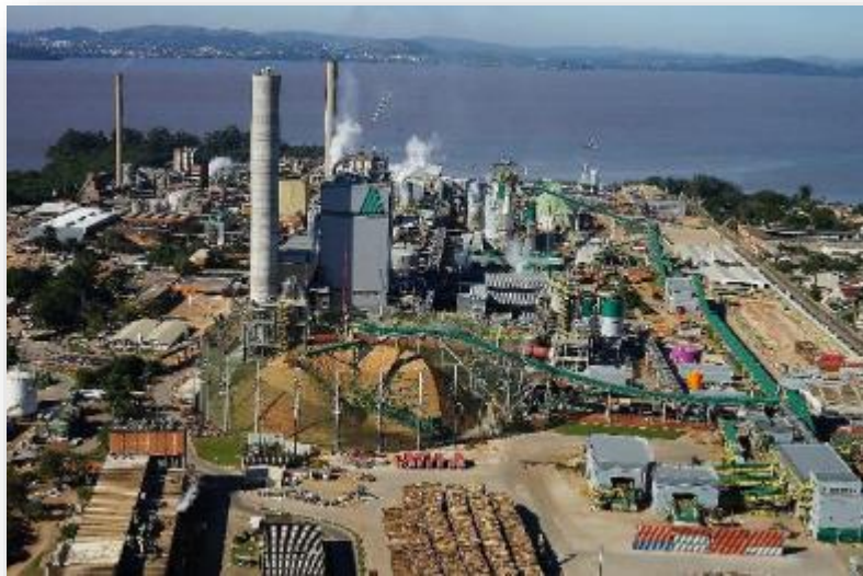
Linha de fibra e energia.
