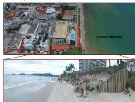
Figura 4: Exposição do terraço no setor centro-leste da praia de Canasvieiras.
