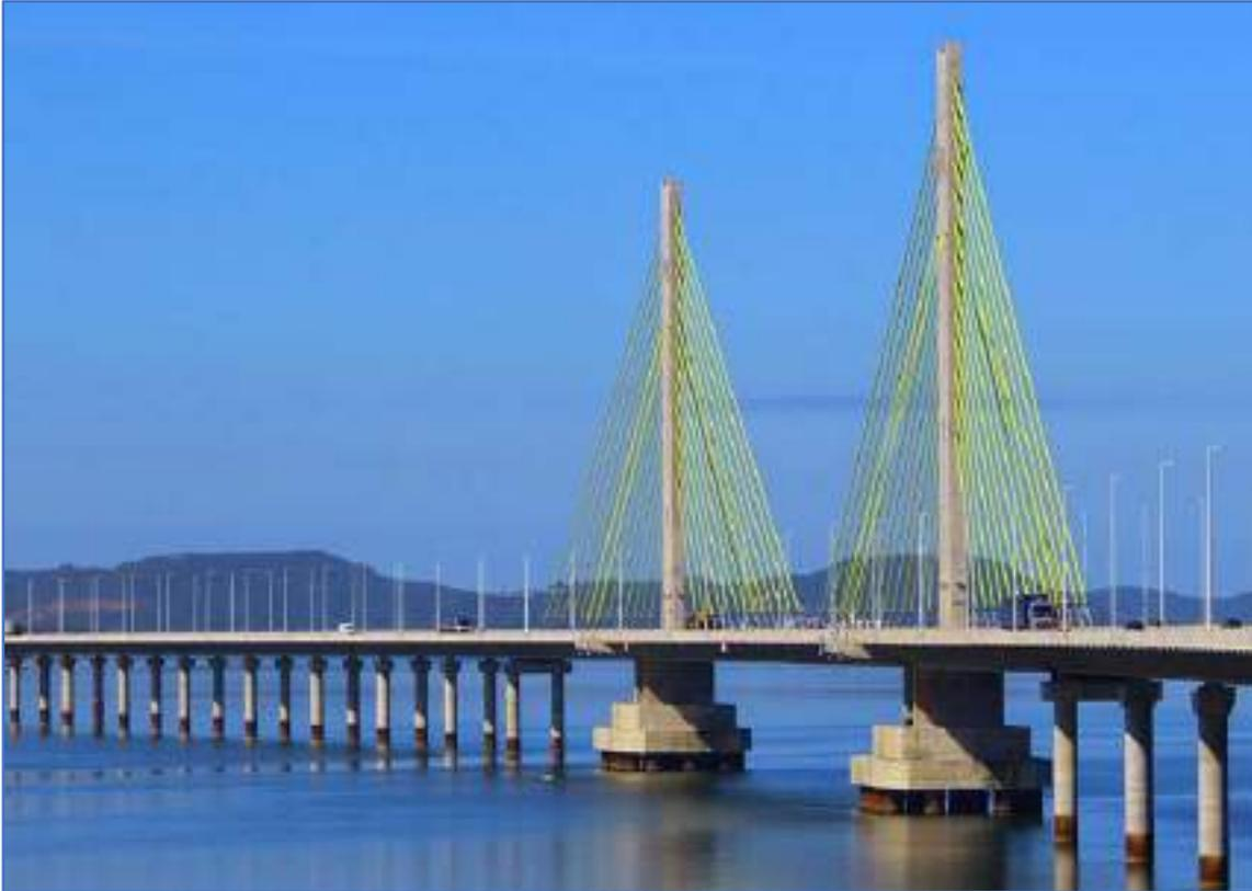
**Figura 55.** Ponte Laguna do tipo estaiada em curva, situada entre as lagoas Santo Antônio e Imaruí no litoral Centro-sul catarinense, construída em julho de 2015, com 2.800m de extensão e 25m de largura.
