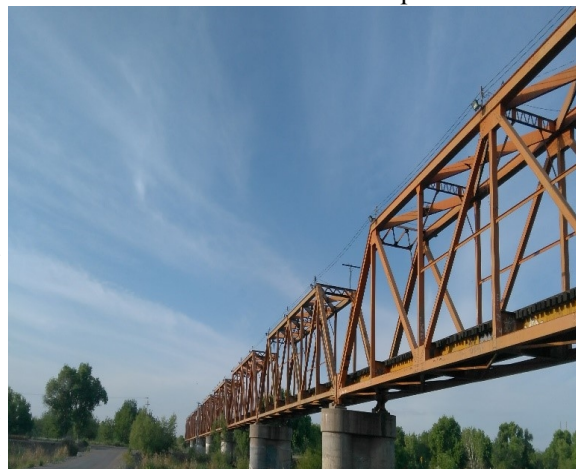
Figura No. 7 Puente ferroviario en Mecoqui Chih
