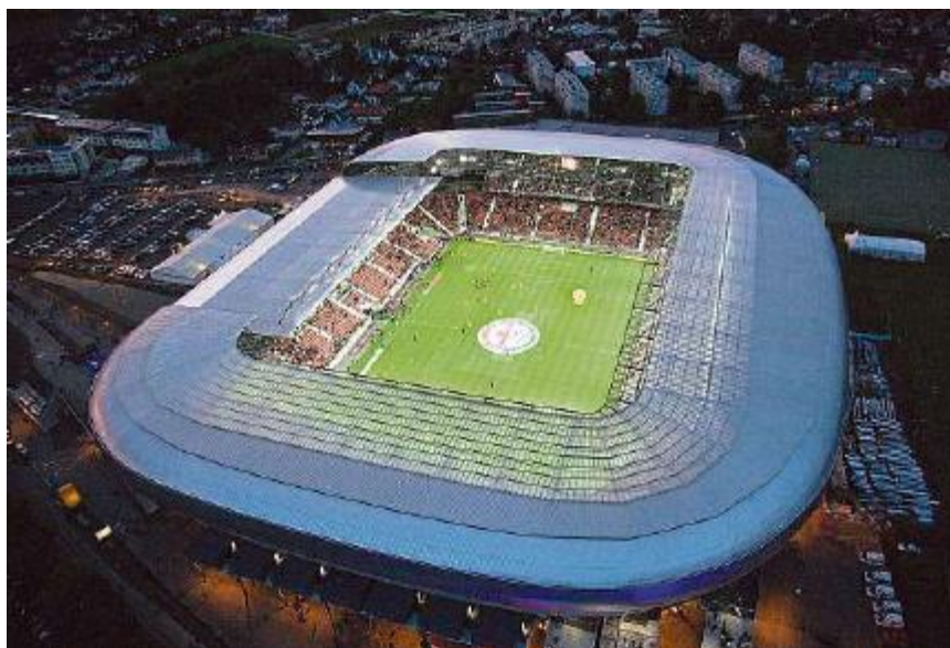
Neue Aufgabe für Stadion gesucht. Das Klagenfurter Stadion (Architekt Albert Wimmer) steht seit der Fussball-Europameisterschaft 2008 meist leer. Foto Gert Steinhilber
