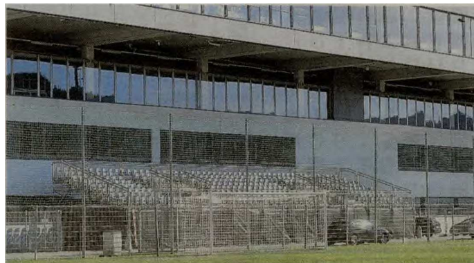
Als Überdachung der Osttribüne hält die EM-Arena her
