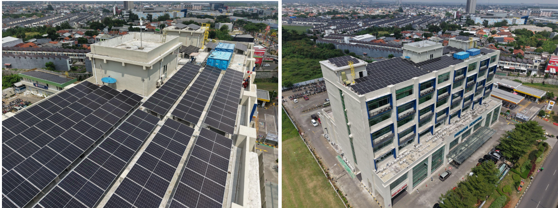
Keterangan foto: Penampakan PLTS atap seluas 1.123 m 2 di Primaya Hospital Karawang
