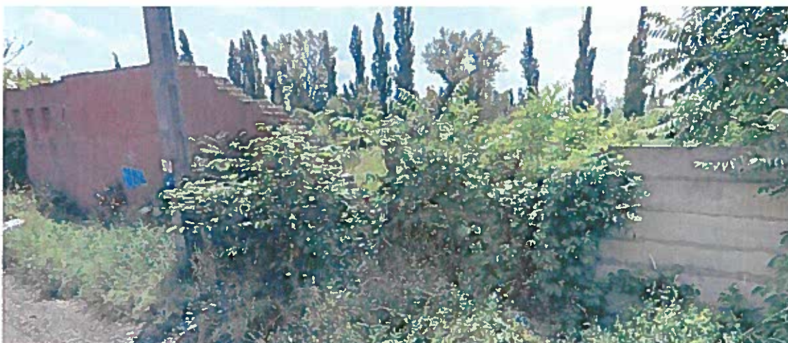
A Fűzfa köz felől szintén betontáblás épített kerítés található a telekhatáron.
