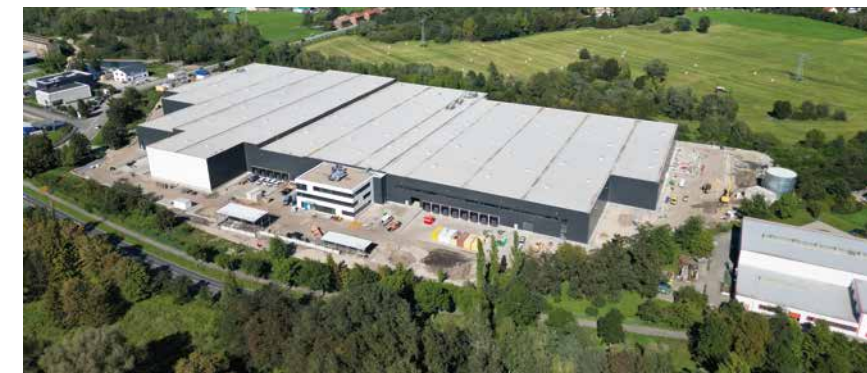
Unten: Auf dem Weg der Fertigstellung ist der ecoPARK Leipzig-West, dessen Dach begrünt und mit Photovoltaik ausgestattet wird.
