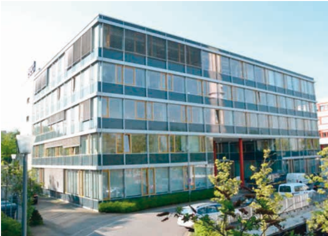
Kruppstraße 82-100, Essen Gesamtfläche: 25.000 m 2
