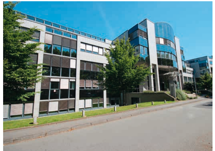
Westfalendamm 94-100 / Voßkuhle 38, Dortmund Gesamtfläche: 22.300 m 2
