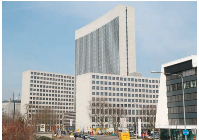
Alfred-Herrhausen-Allee 3-5, Eschborn Gesamtfläche: 41.000 m 2
