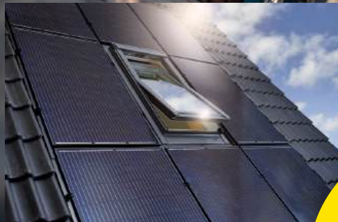
NUR VOM DACHDECKER: DIE INDACH PV-ANLAGE
