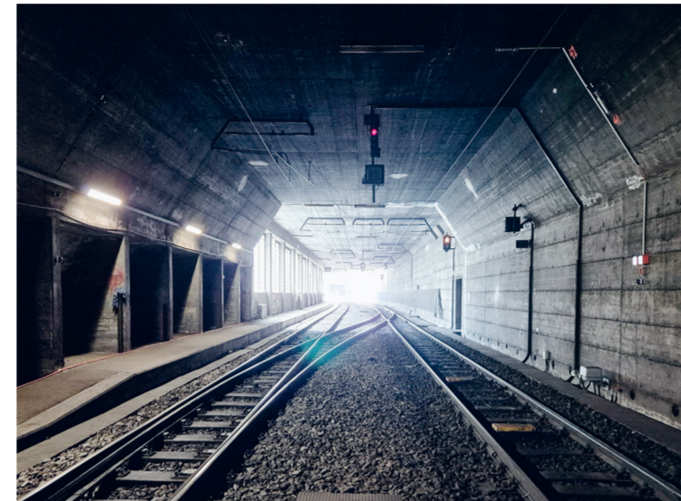
Diese Weichen am Bahnhof Zermatt werden im September ausgetauscht.
